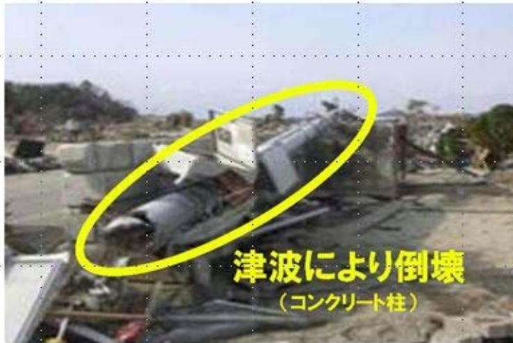
①基地局設備 (宮城県 松島野蒜設置)
